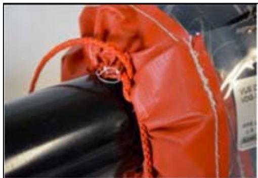
6. Asegurar los cordones adicionales insertándolos en la solapa o envolverlos alrededor del diámetro exterior de la tubería y unirlos.
